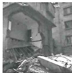
(地震で崩壊したカトマンズ市内の住宅)
